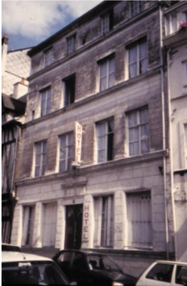
Fig. 17: Casa de J.B. Trehet en el n° 130 de la calle Beauvoisine.
