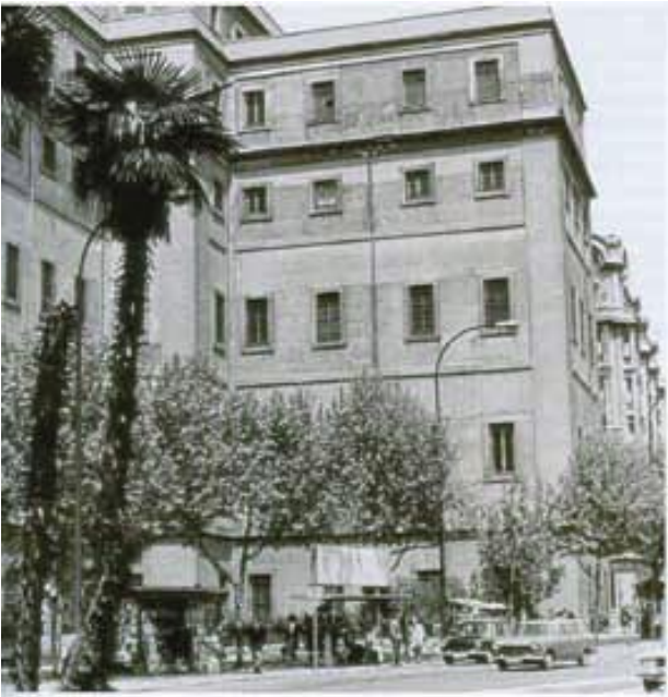
FIGURA 9. El antiguo edificio visto desde la Ronda de Atocha.
