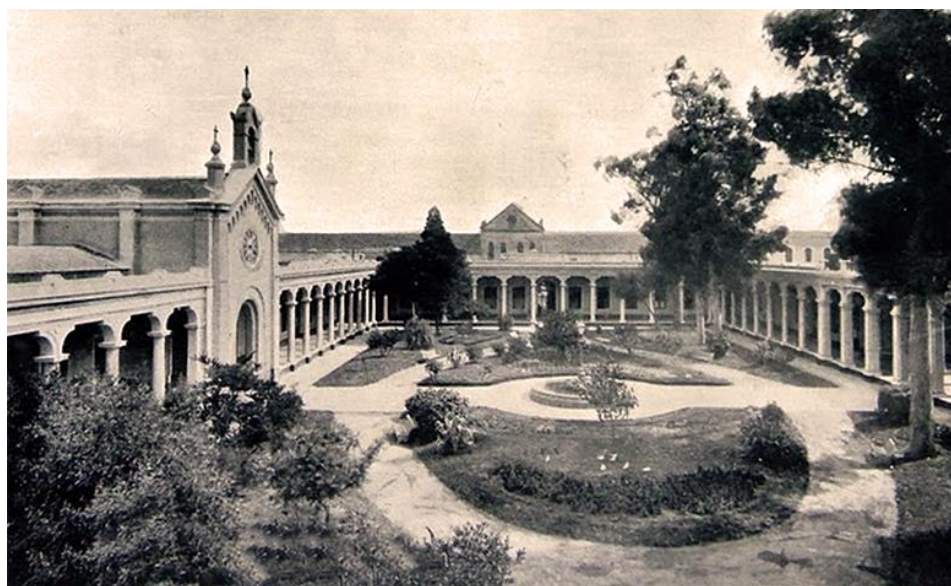
Figura 5. Antiguo Hospital San Roque de Buenos Aires.
