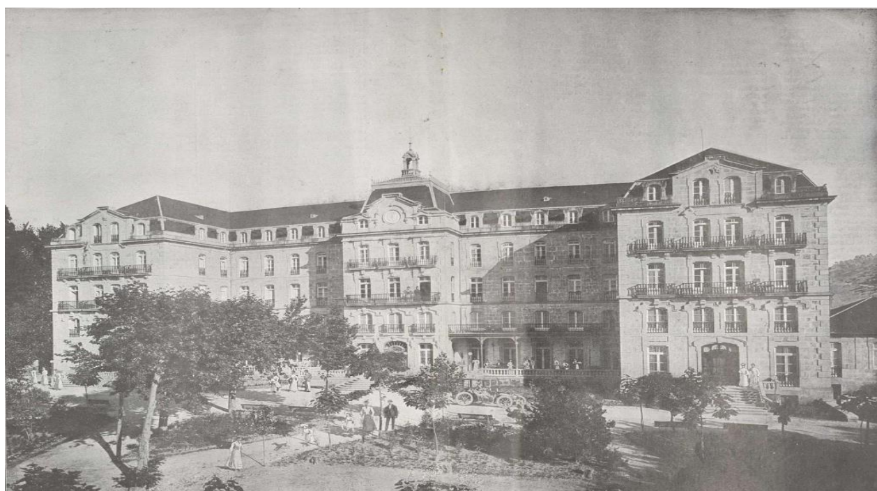
Figura 4. Gran Hotel, interior en tarjeta postal (A) y fachada (B) publicada en La Temporada de Mondariz, 1909.
