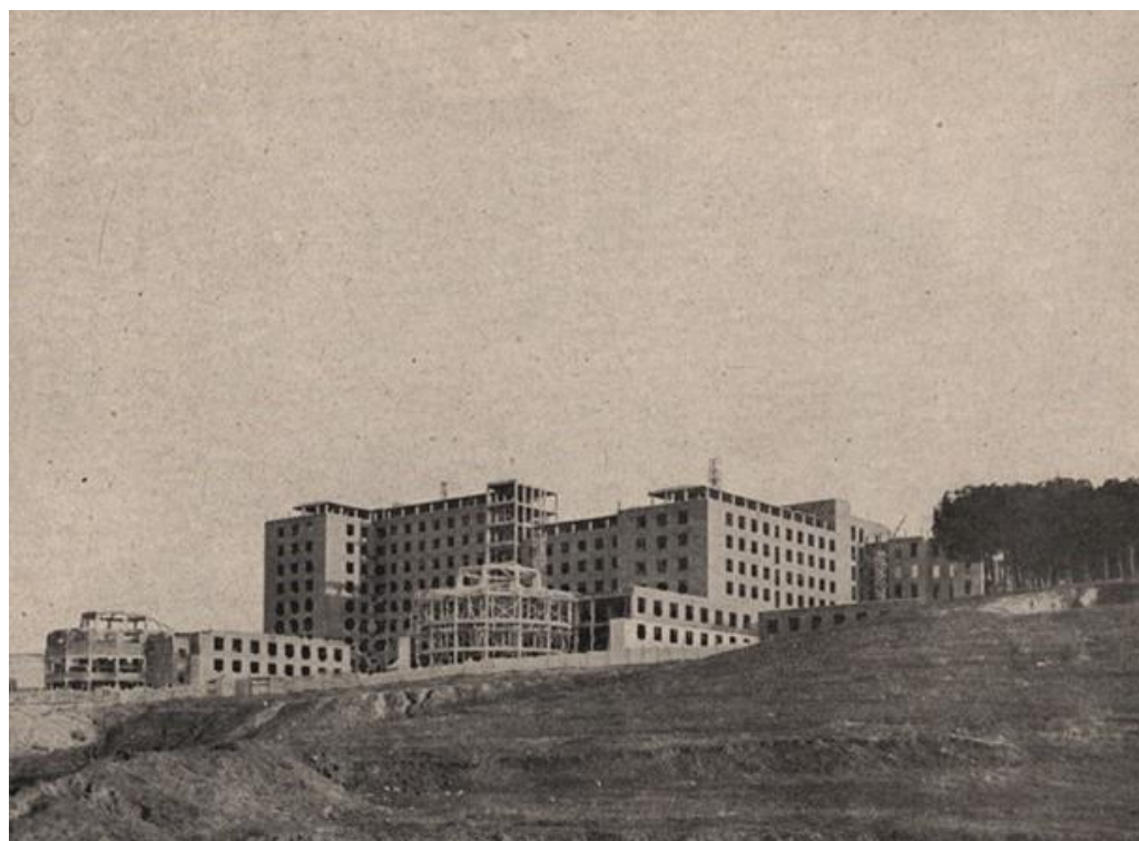
Figura 6. Ciudad Universitaria de Madrid, Hospital Clínico San Carlos en construcción. Servicio Histórico del Colegio Oficial de Arquitectos de Madrid (COAM).
